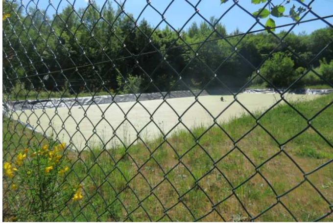
Vue 3 – Vue sur le bassin de gestion des eaux de pluie
